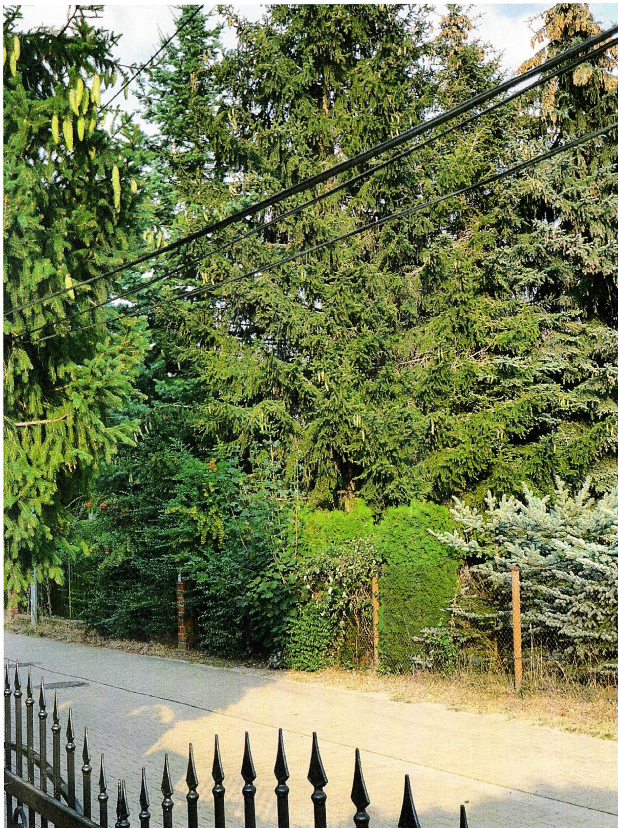
Widok linii przed posesją przy ul. Różanej w Bogdańcu
