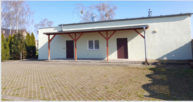
Remont sali wiejskiej w Jeżykach
