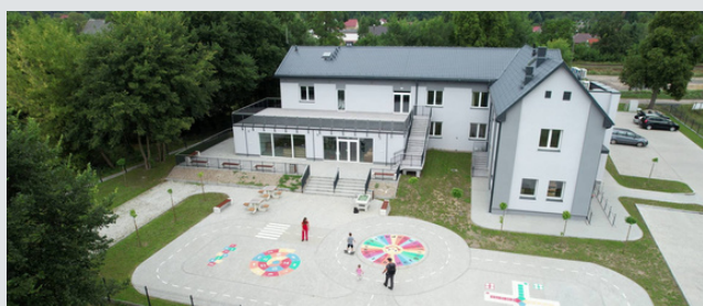
Remont Gminnej Biblioteki Publicznej w Bogdańcu
