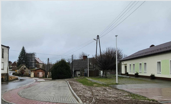
Budowa Chodników oraz parkingów w Stanowicach
