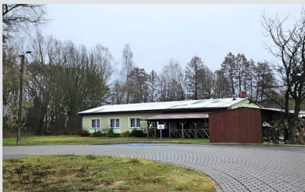
Budowa zatoki autobusowej w Chwałowicach
