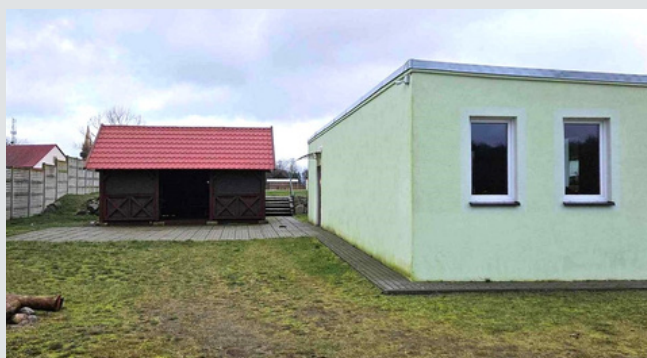
Budowa budynku socjalnego w Podjeninie
