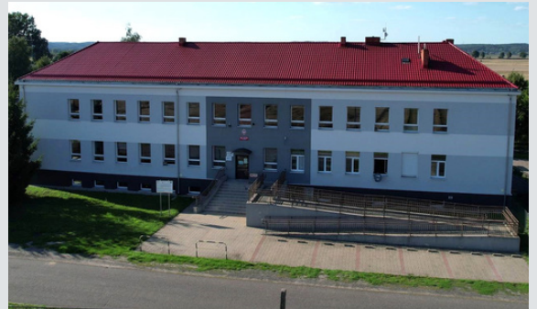
Termomodernizacja Szkoły Podstawowej w Lubczynie
