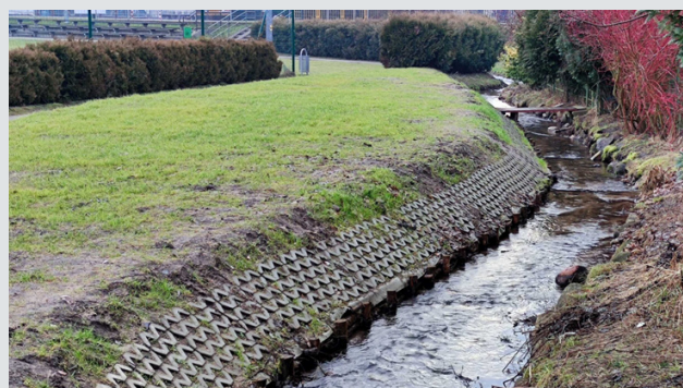
Konserwacja kanału Bogdanka
