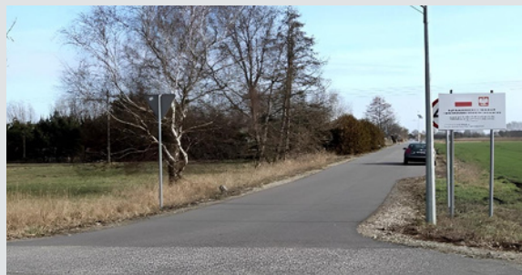
Przebudowa drogi w Kwiatkowicach
