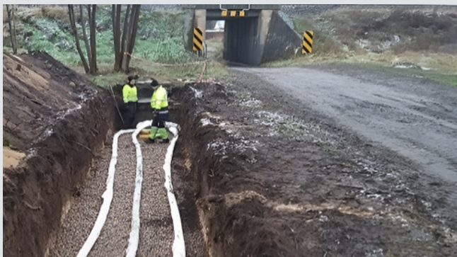
Wykonanie drenażu rozsączającego na ul. Topolowej w Łupowie
