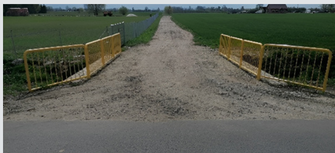
Przebudowa przepustu na kanale wieprzyckim
