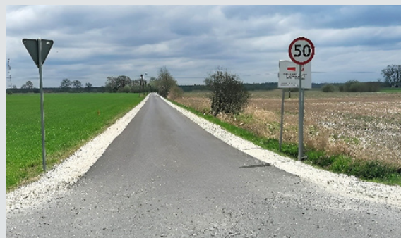
Budowa drogi Chwałowice - Roszkowice - Włostów
