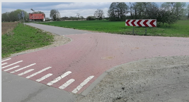
Przebudowa dróg gminnych w Lubczynie i Jasińcu
