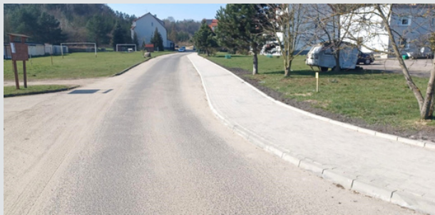
Budowa chodnika na ul. Leśników w Łupowie
