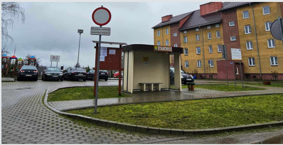
Przebudowa zatok autobusowych w Stanowicach
