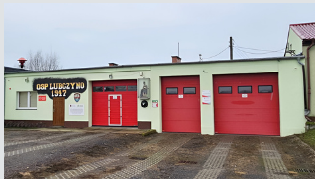
Remont remizy OSP w Lubczynie
