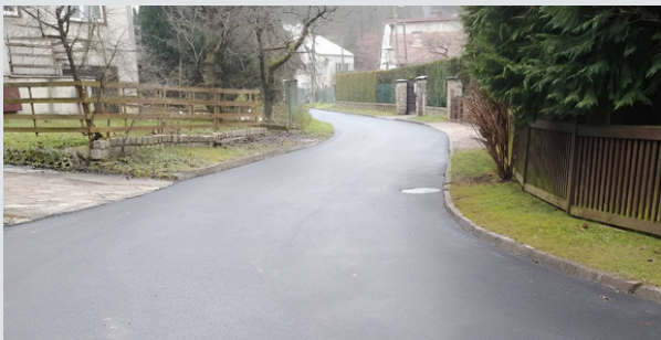
Przebudowa drogi Osiedle Przylesie w Jeninie
