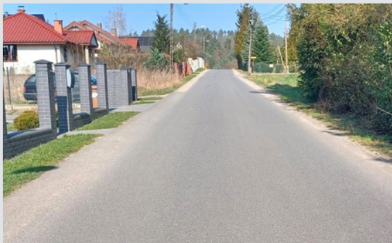
Budowa ul. Akacjowej w Jeninie
