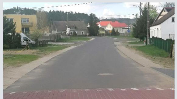
Przebudowa ul. Słonecznej w Jeninie
