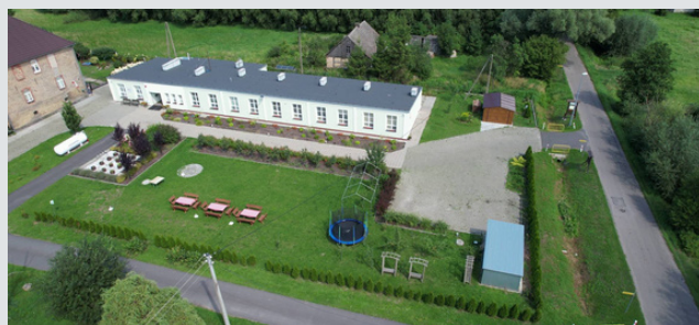
Budowa Środowiskowego Domu Samopomocy w Krzyszczynie
