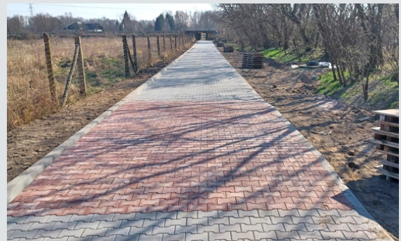
Budowa ul. Polnej w Łupowie
