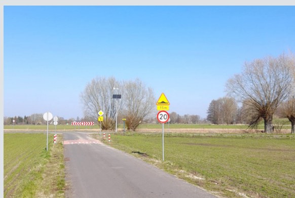
Budowa drogi Chwałowice - Roszkowice
