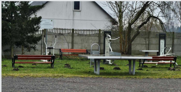
Montaż siłowni napowietrznej przy OSP w Lubczynie
